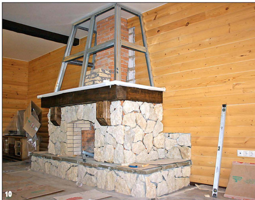
Из металлического профиля собран каркас для колпака камина.
