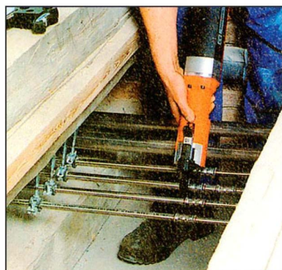
Соединение опрессовкой труб из высокосортной стали, отличающихся высокой стойкостью к коррозии. Такие соединения выполняются сравнительно быстро (фирма Mappress).
