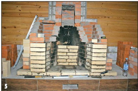
5 Передние стенки камина выдвинуты вперёд на полкирпича.
