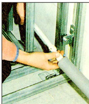
Выпрямленные трубы соединяют вставным способом. Воспринимаемый на слух лёгкий щелчок свидетельствует о том, что соединение выполнено правильно (фирма Friatec).
