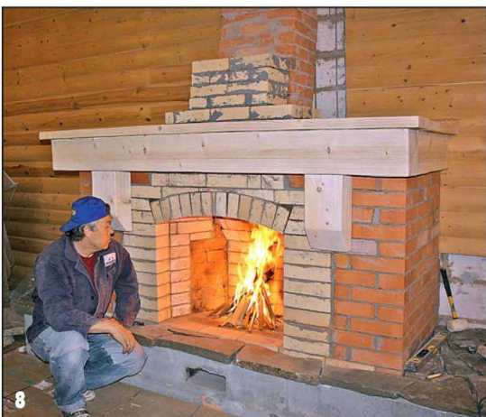
8 Пробная топка после подключения камина к трубе.
