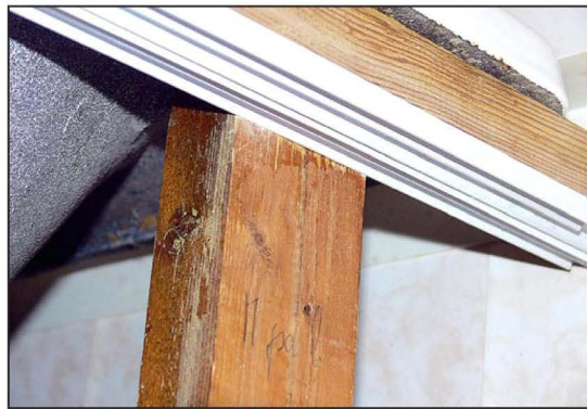
Верхний горизонтальный брусок крепится к стойке шурупом с тыльной стороны.
