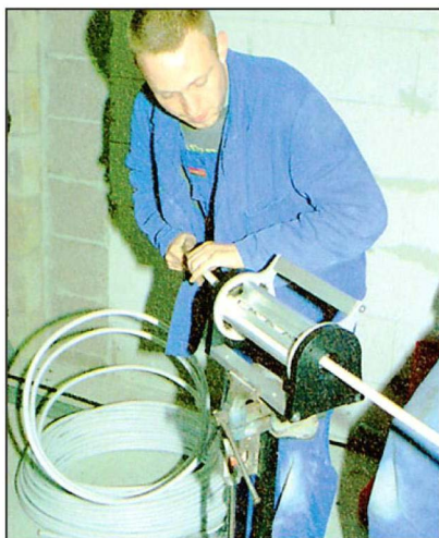
Разматываемые из рулона гибкие пластиковые трубы выпрямляют с помощью трубоправильного устройства, подготавливая их к использованию в трубопроводе отопительной системы.
