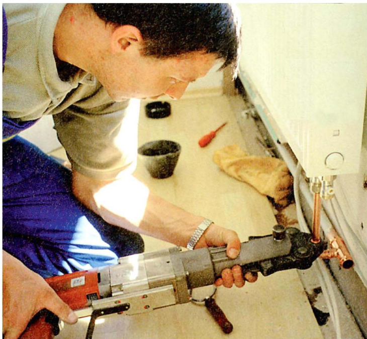
Современные пластиковые трубы можно без каких-либо проблем соединять с металлическими или со стояками из пластика.
