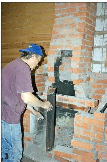
Портал старого камина был перекрыт по стальному уголку.
