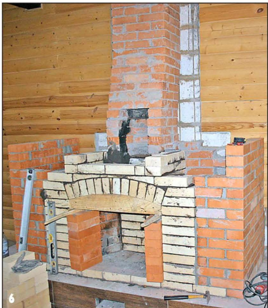
6 Арочную перемычку выкладывал по деревянному шаблону.
