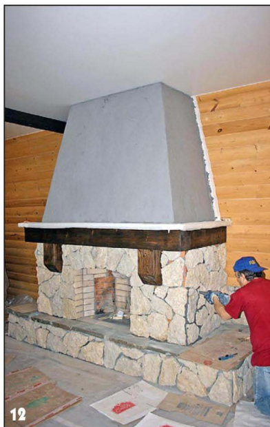
Заделка швов каменной облицовки камина.
