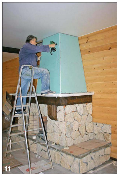
Обшивка каркаса гипсокартоном при устройстве колпака камина.
