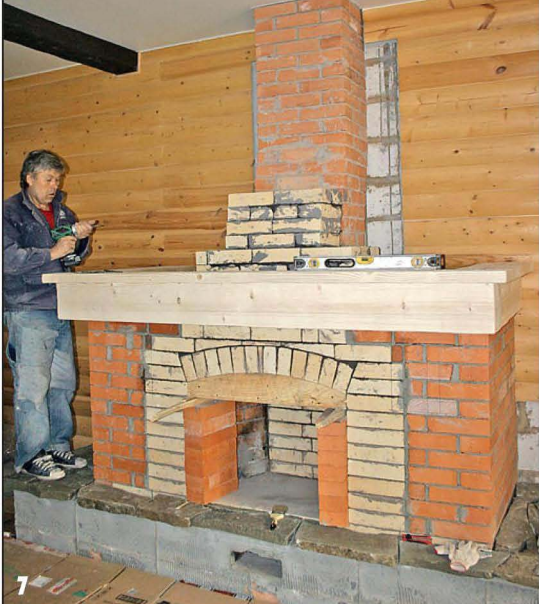
7 Монтаж бруса каминной полки.
