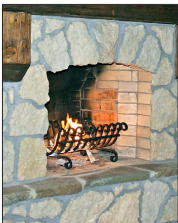
Для равномерного сгорания дров в топках с глухим подом используют металлические корзины.
