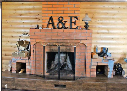
Камин до реконструкции.
